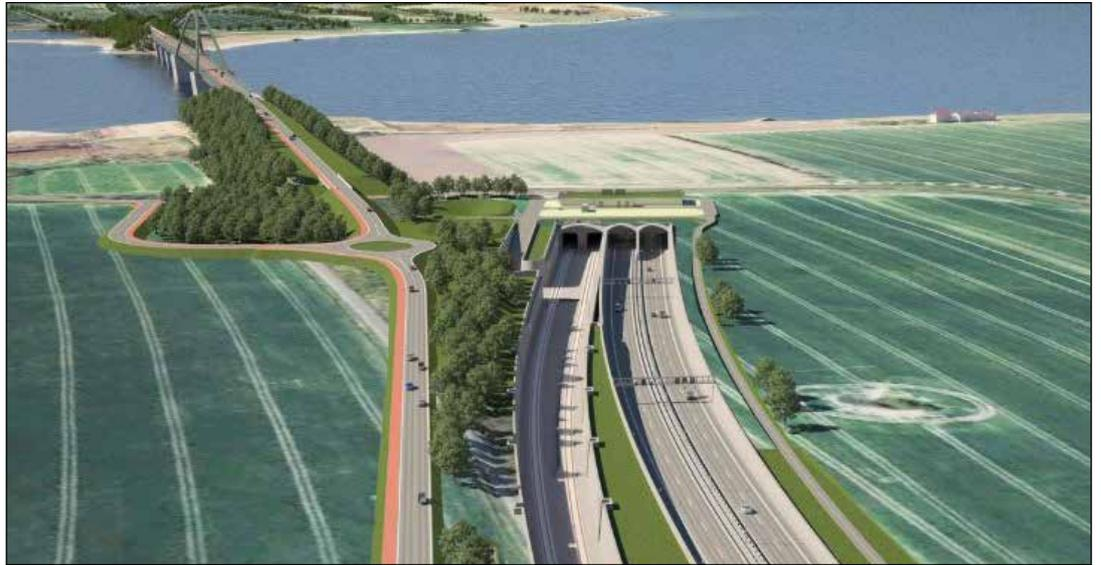
Ein kombinierter Absenktunnel für Straße und Schiene soll in einigen Jahren Fehmarn mit dem ostholsteinischen Festland verbinden. Darstellung: Deutsche Bahn
