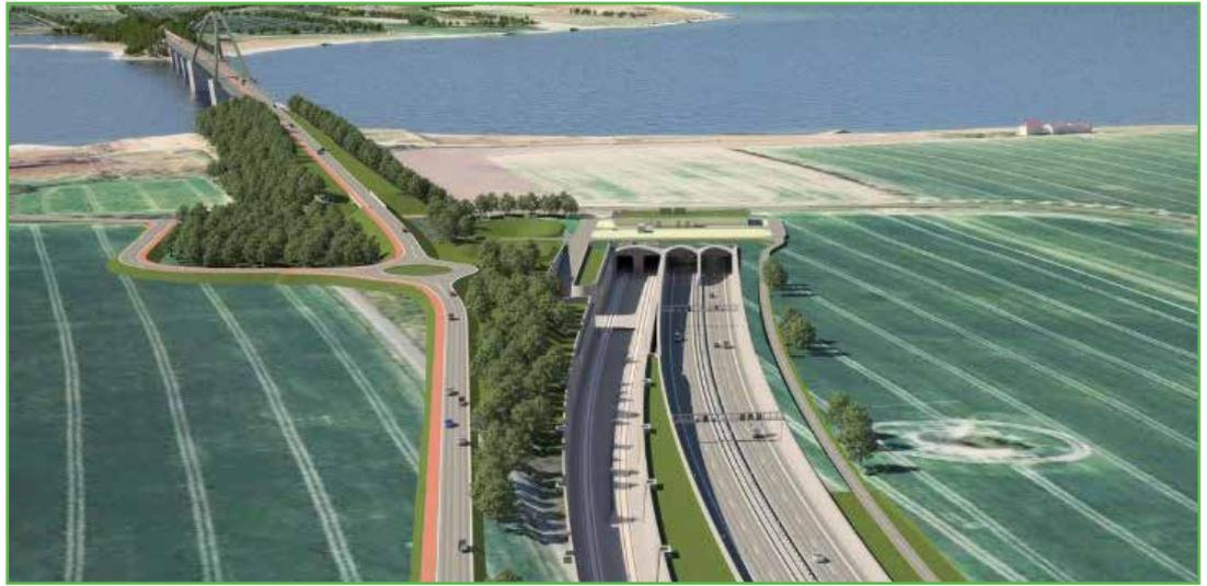
Ein kombinierter Absenktunnel für Straße und Schiene soll in einigen Jahren Fehmarn mit dem ostholsteinischen Festland verbinden. Darstellung: Deutsche Bahn
