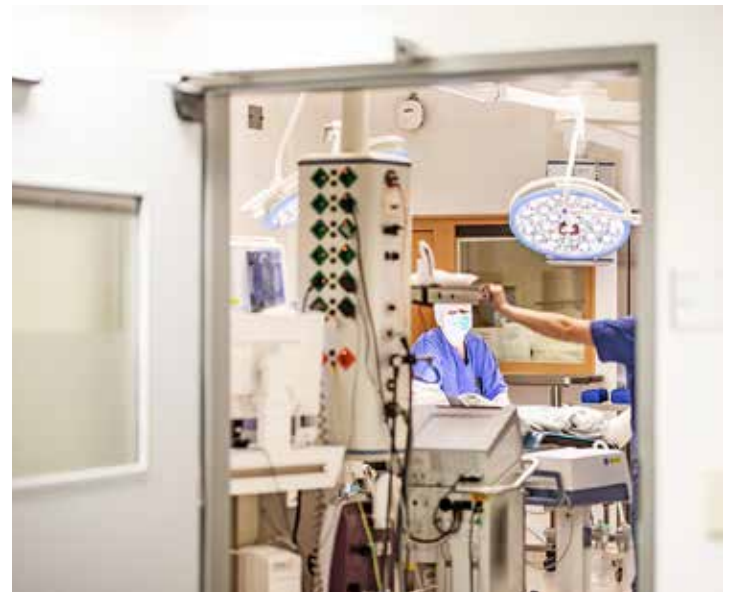
Modernste Technik prägt den neu entstehenden OP-Bereich.
