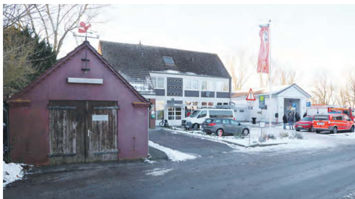
Neben dem alten Gebäude erstrahlt die neu fertiggestellte Fahrzeughalle, die am 10. Januar feierlich eingeweiht wurde.
