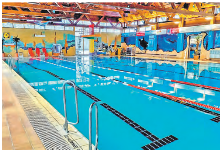
Am 14. Januar wurde die Schwimmhalle wiedereröffnet, ein Jahr nach der Schließung für die Sanierungsarbeiten. Vor allem die technischen Anlagen im Keller wurden von Grund auf erneuert. Fotos: vg/hfr
