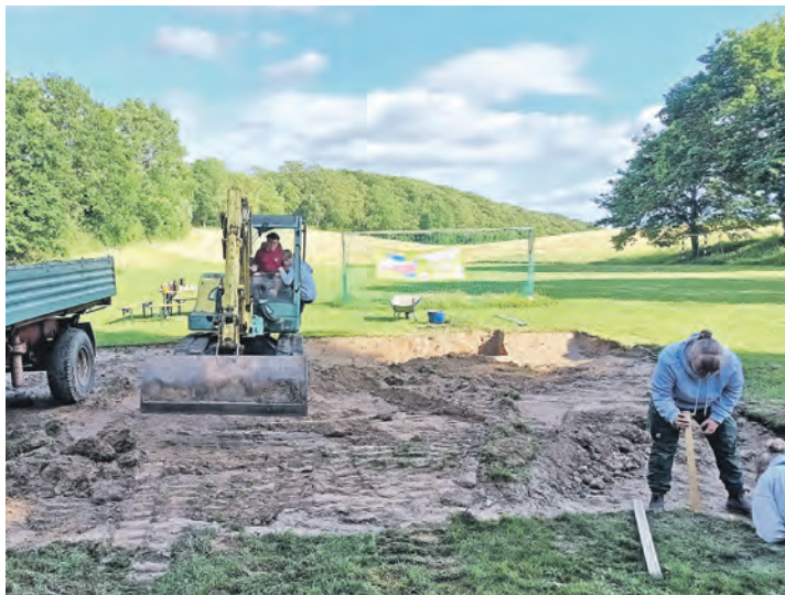
Ein ausgekoffertes Stück Rasenfläche in der Größe eines Volleyballfeldes wurde zunächst mit Sand aufgefüllt.
