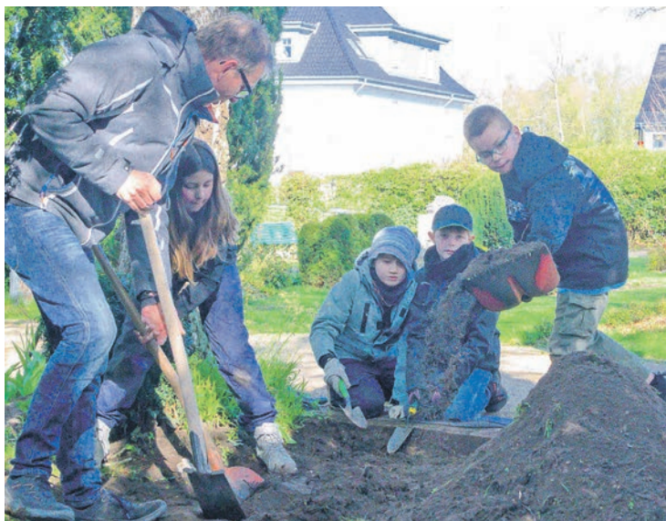
Umweltbeauftragter Ludwig Askemper hat mit seiner Gruppe eine tiefe Mulde ausgehoben, in der sich bei heftigen Güssen Regenwasser sammelt.
