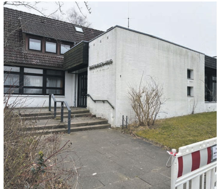
Der Beschluss steht: In den nächsten Monaten wird das Bughenhagenhaus im Waldweg abgerissen. Foto: Graap
