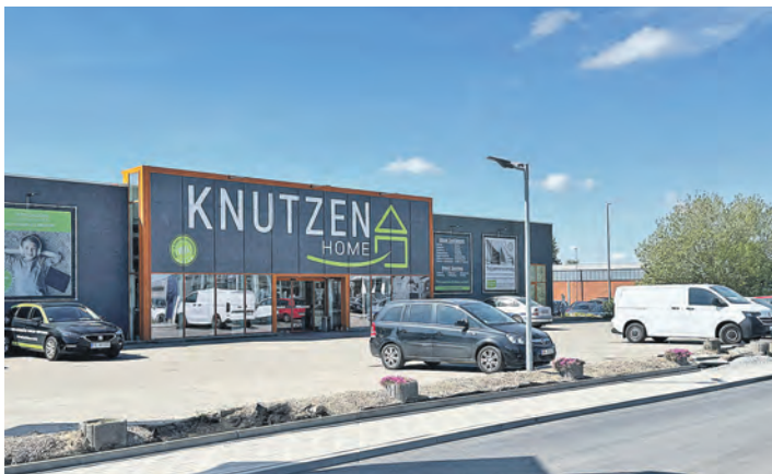
Die Filiale von Knutzen Home, Am Voßberg 8 in Oldenburg.
