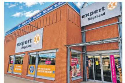
„expert MegaLand“ in der Johann-Specht-Straße 5-7 in Eutin wird umfassend umgebaut. Fotos: hfr
