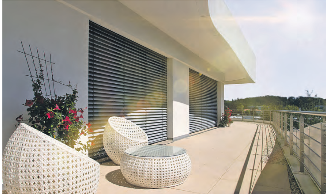
Außenliegender Sonnenschutz hält bis zu 90 Prozent der Wärme von den Innenräumen ab.
