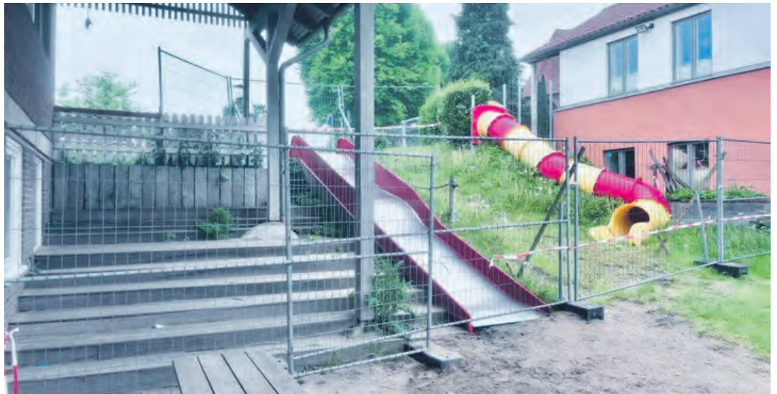
Der Rutschenhang ist seit Monaten gesperrt.
