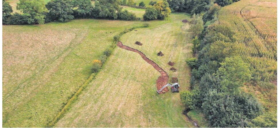
Diese Fotos stammen von Bau- phase sowie von einer fertigge- stellten Gewässeraufweitung.
