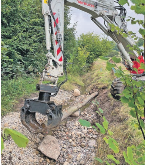
Diese Fotos stammen von Bau- phase sowie von einer fertigge- stellten Gewässeraufweitung.
