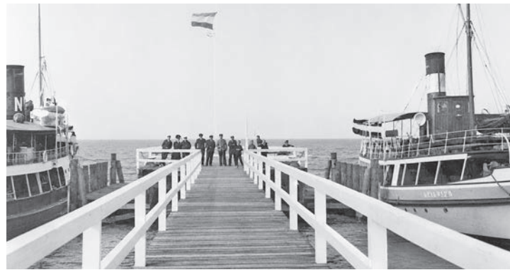
Im Jahre 1912 wurde die erste Seebrücke eingeweiht.
