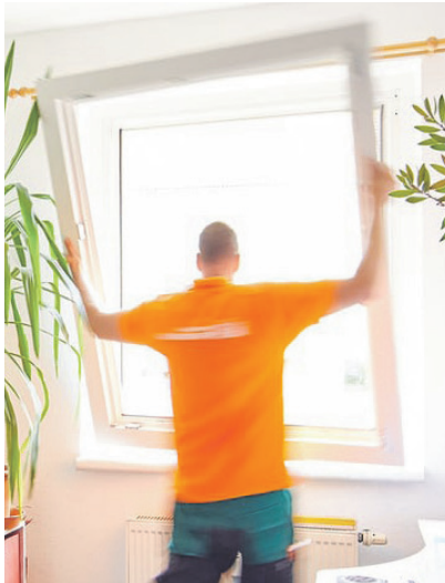
Mit der Einschubmontage ist der Fenstertausch schon in rund einer Stunde erledigt. Foto: Finstral
