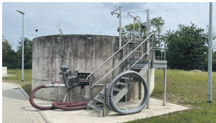
Ein Becken der alten Kläranlage. Dieses und ein weiteres Becken lassen sich mit aktueller Technik weiter nutzen. Foto: Münch
