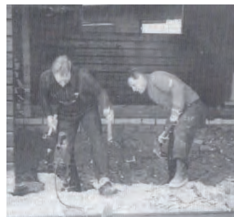
Ehrenamtliches Engagement machte 1994 eine umfassende Sanierung und Erweiterung des Sportheims möglich.
