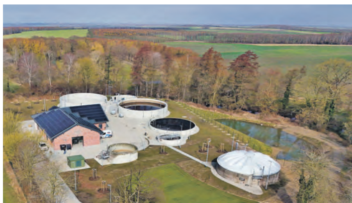
So sieht das Klärwerk Probsteierhagen aus der Vogelperspektive aus. Foto: ZVO/hfr
