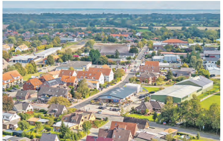
Luftaufnahme vom vergangenen Herbst, das die wandernde Baustelle rund um den Eichkamp zeigt. Fotos: hfr
