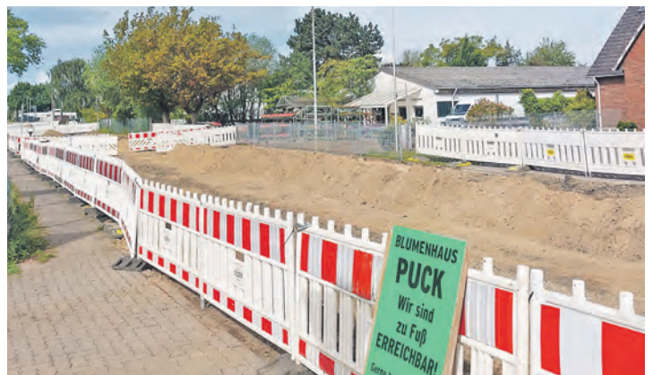
Die Baustelle im Eichkamp lässt Fußgänger passieren.
