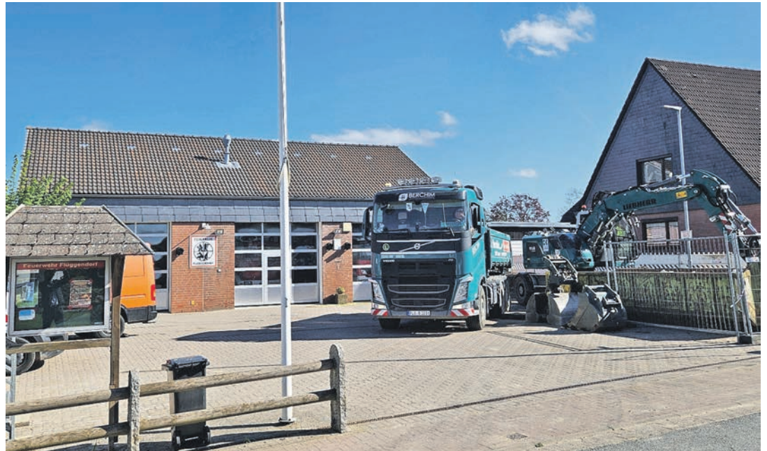
Die Arbeiten zur Modernisierung und Erweiterung des Feuerwehrgerätehauses haben Mitte April begonnen. Im rückwärtigen Bereich entstehen ein Anbau und 18 Pkw-Stellplätze.
