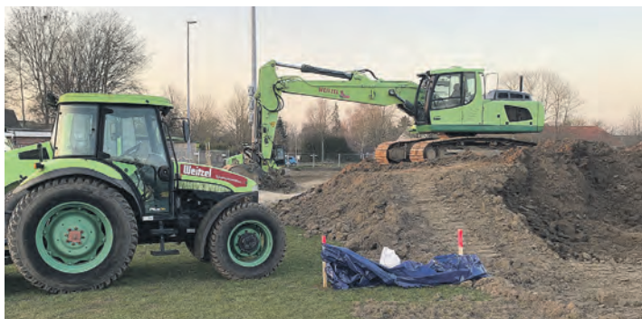
Seit voriger Woche haben die Bauarbeiten begonnen. Mit großen Baumaschinen entsteht eine neue moderne Sportstätte. Fotos: Schröder
