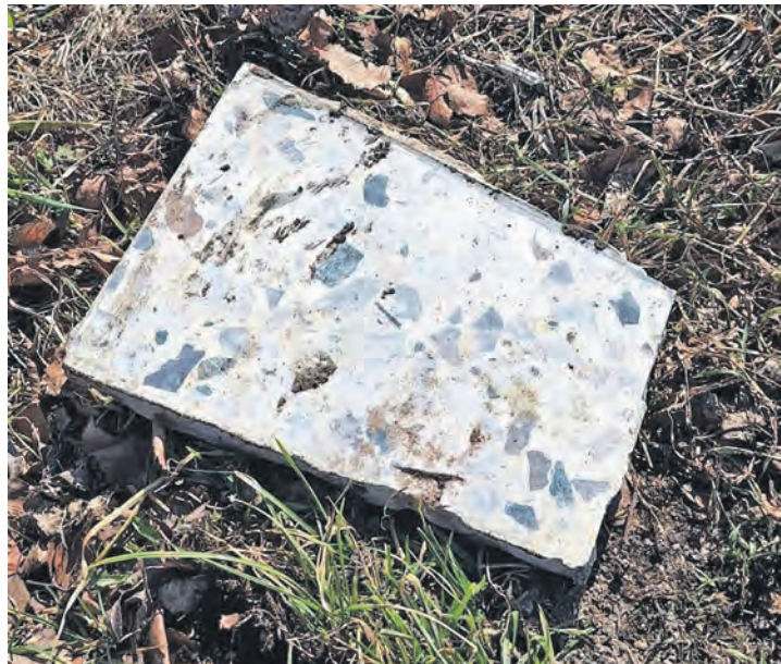
Die entsorgte Bodenplatte.
