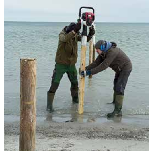
Mit einer Motorramme werden die Pfähle eingetrieben.
